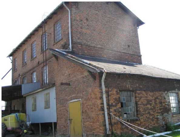
Widok od północnego-zachodu
